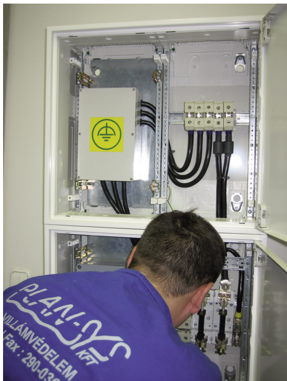
Szűrőegység(ek) helyszíni telepítése
