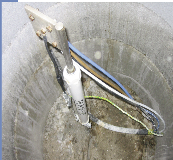
Zavarszűrőfejes földelőszonda aknába telepítve
