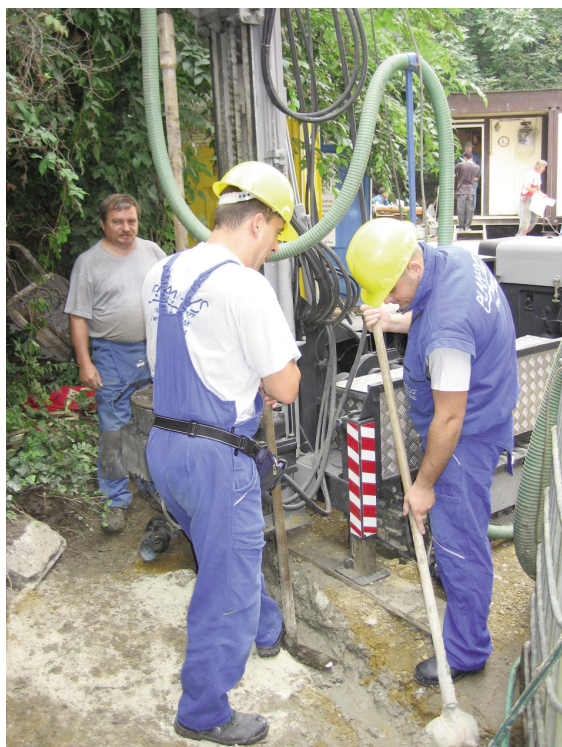
Koracél mélyföldelő szondák telepítése, akna kialakítása fúrásos eljárással
